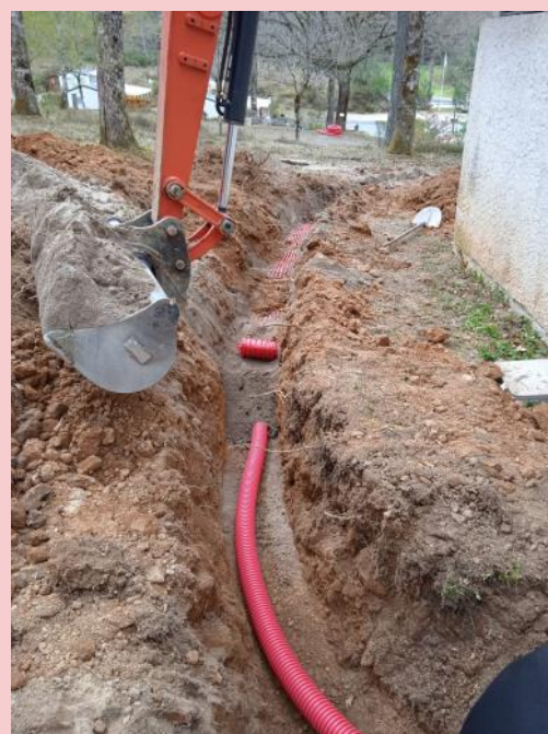
Enfouissement gaine électrique au Camping municipal
